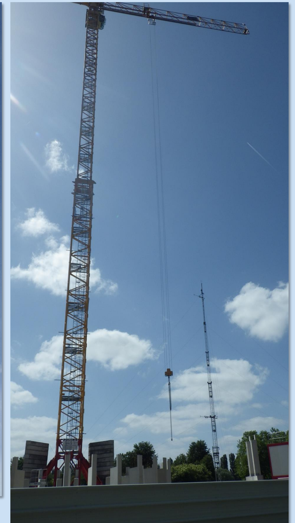
Zone 4 le 03 Juin Zone de construction du radar d'Orly
